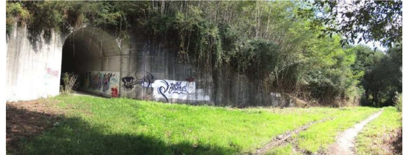
Obra de paso bajo la Avda. Xosé Filgueira Valverde
