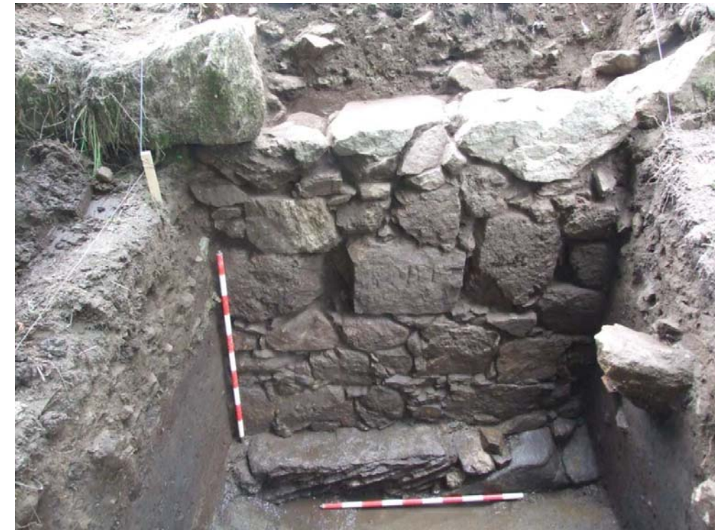
Muro de contención paralelo al Camino de Santiago.
