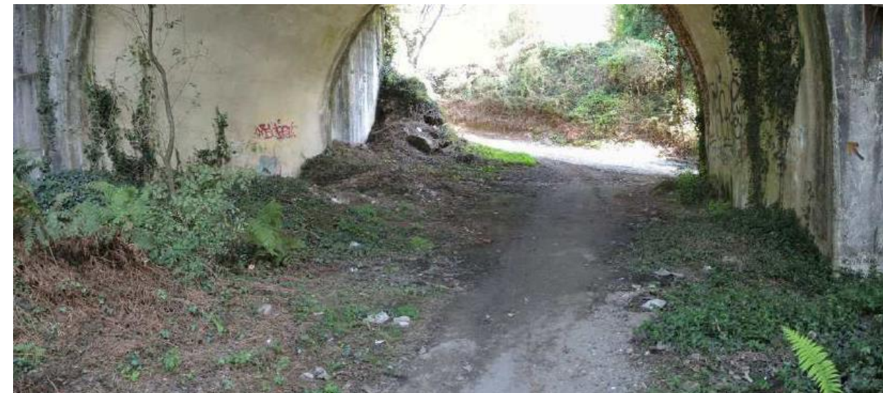
Paso del Camino bajo la carretera SC-20 (carretera a Pontevedra)
