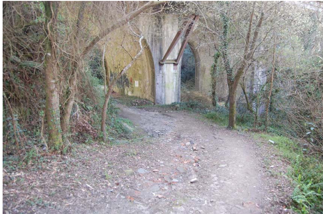
Foto 4: Viaducto de La Rocha.
